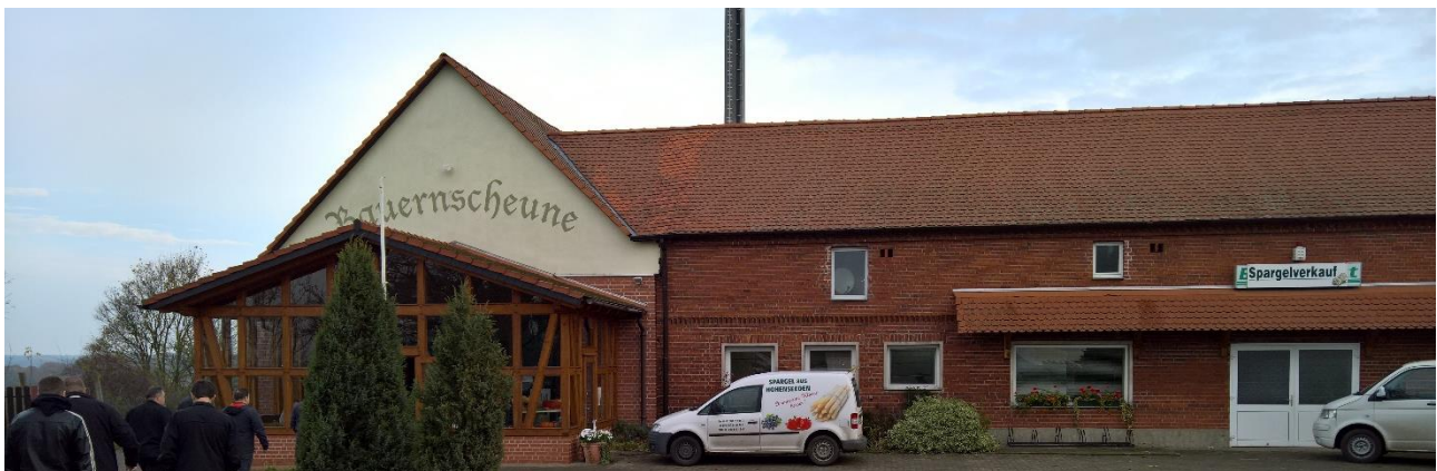
Kuva 59. Maatalousosuuskunnan päärakennuksessa sijaitsee mm. myymälä ja juhlatila.
